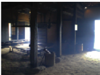
【旧平田家住宅母屋内部】 大黒柱登場前の建築なので細い柱が何本も立っている
